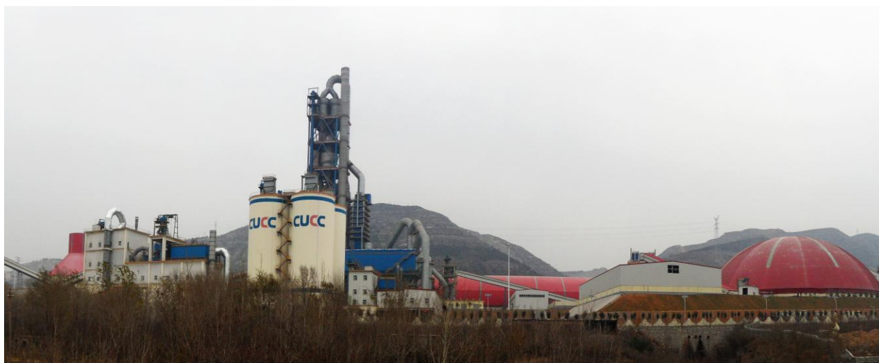
图 5 改造后的水泥生产线全貌
